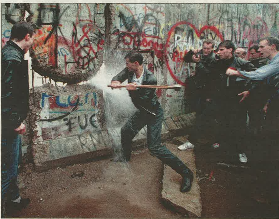
Le prime picconate il 9 novembre del 1989 dopo il via libera delle autorità inizio la distruzione del muro
